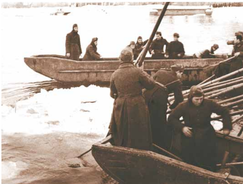
Строеж на понтонен мост, с. Батина
